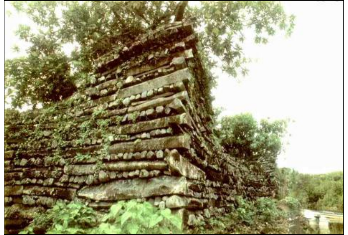
南塔瓦西石構城市圍牆
